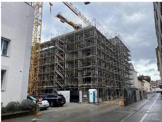
Baustelle am 13. März 2023
