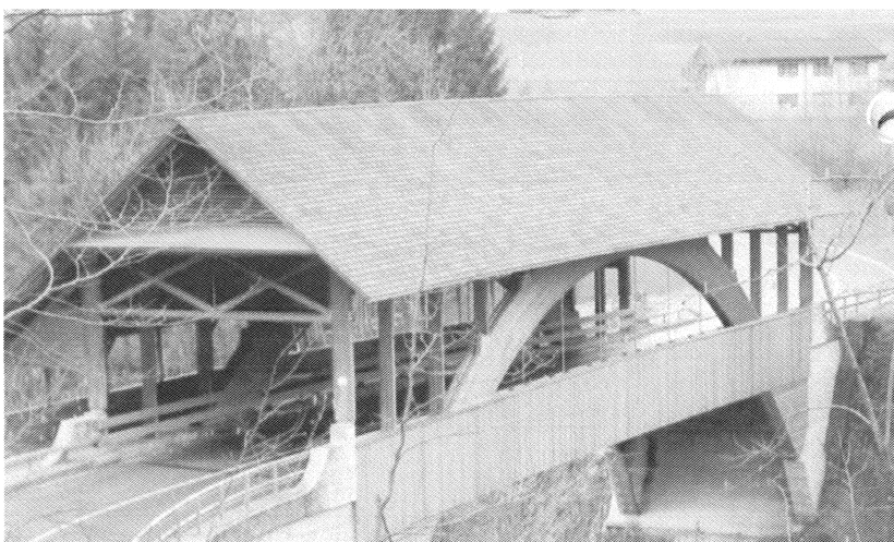
Lochermoosbrücke Ganterswil SG zugelassen 40 t, 1994. 2 Fahrbahnen + LV-Fahrbahn
